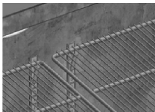
Figura 9: Colocação das grades
